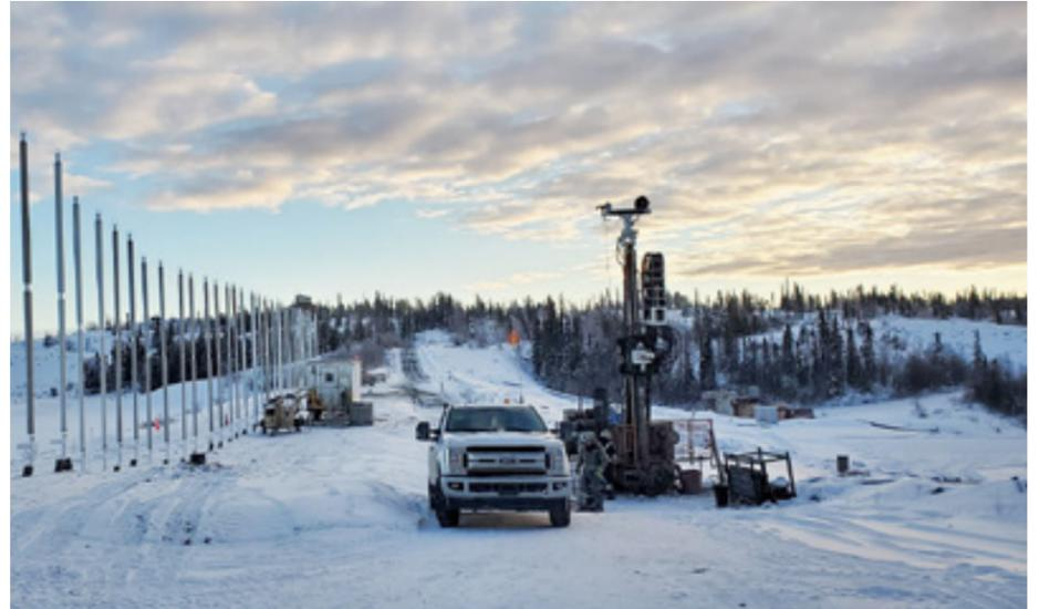
L'équipe de projet a installé 38 thermosiphons passifs. Ces tuyaux verticaux sont remplis de dioxyde de carbone qui aide à maintenir le sol gelé.
