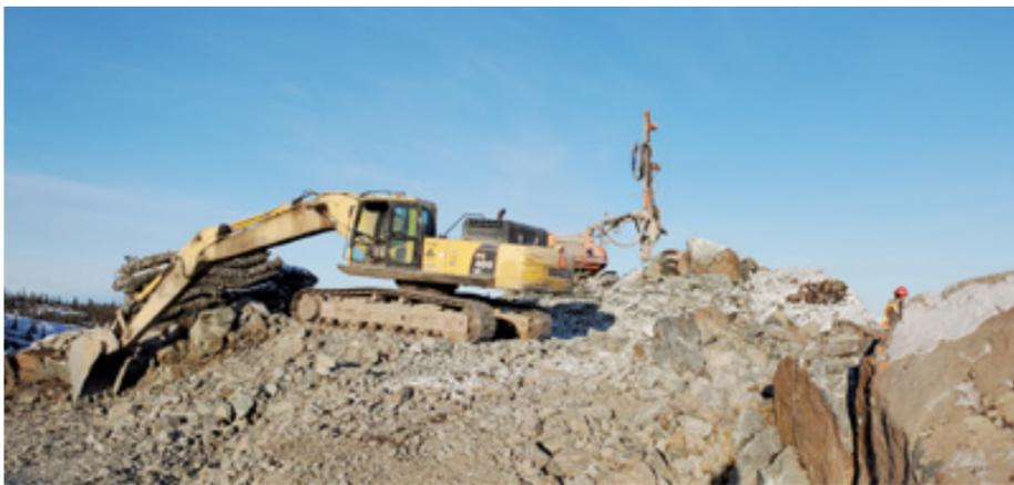
Excavatrice à l'œuvre pour enlever la roche dynamitée et les sols contaminés dans le cadre de la construction d'une plateforme de congélation. (Courtoisie RCAANC)
